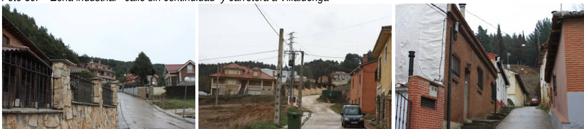
Foto 31. Viales con pendientes acuciadas
