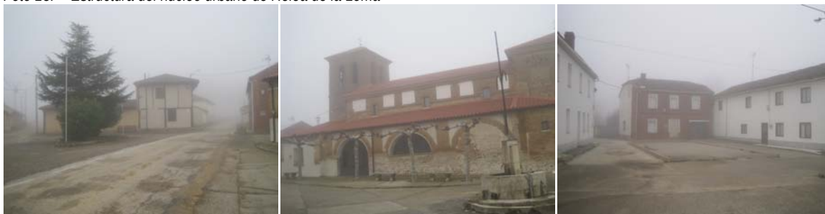
Travesía de la carretera PP-2453
