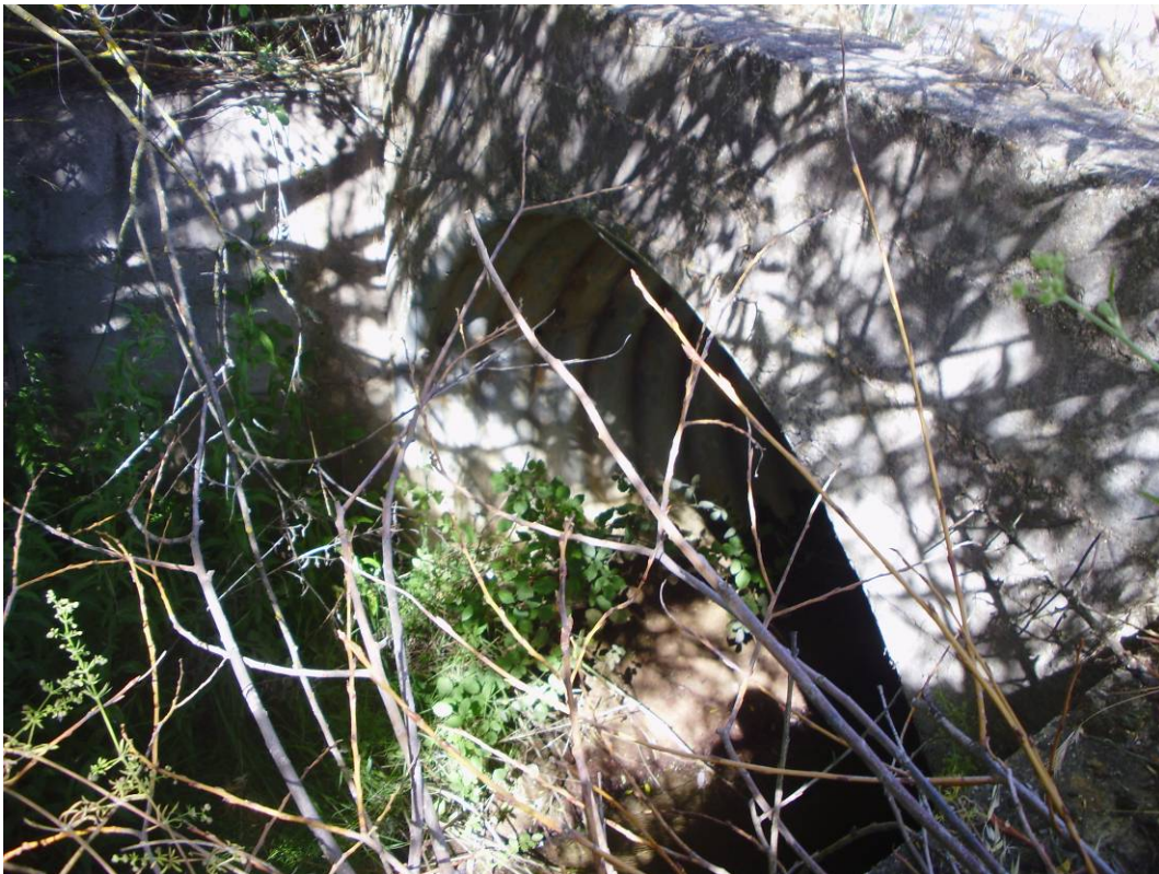
FOTOGRAFÍA 6. Obra de fábrica OD-3 aguas abajo.
