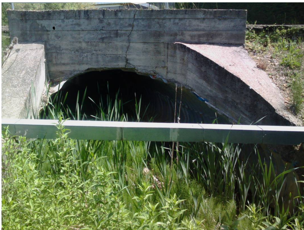
FOTOGRAFÍA 8. Obra de fábrica OD-4 aguas abajo.
