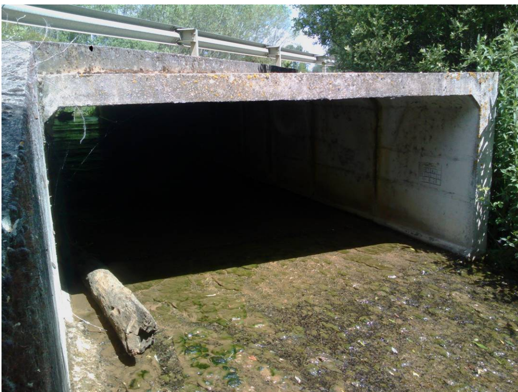
FOTOGRAFÍA 2. Obra de fábrica OD-1 aguas abajo.
