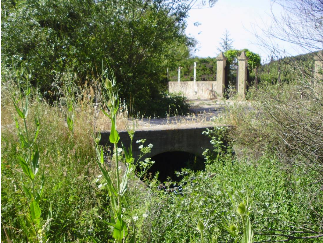
FOTOGRAFÍA 5. Obra de fábrica OD-3 aguas arriba.
