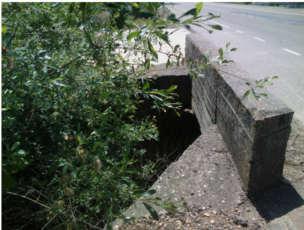
FOTOGRAFÍA 7. Obra de fábrica OD-4, aguas arriba.
