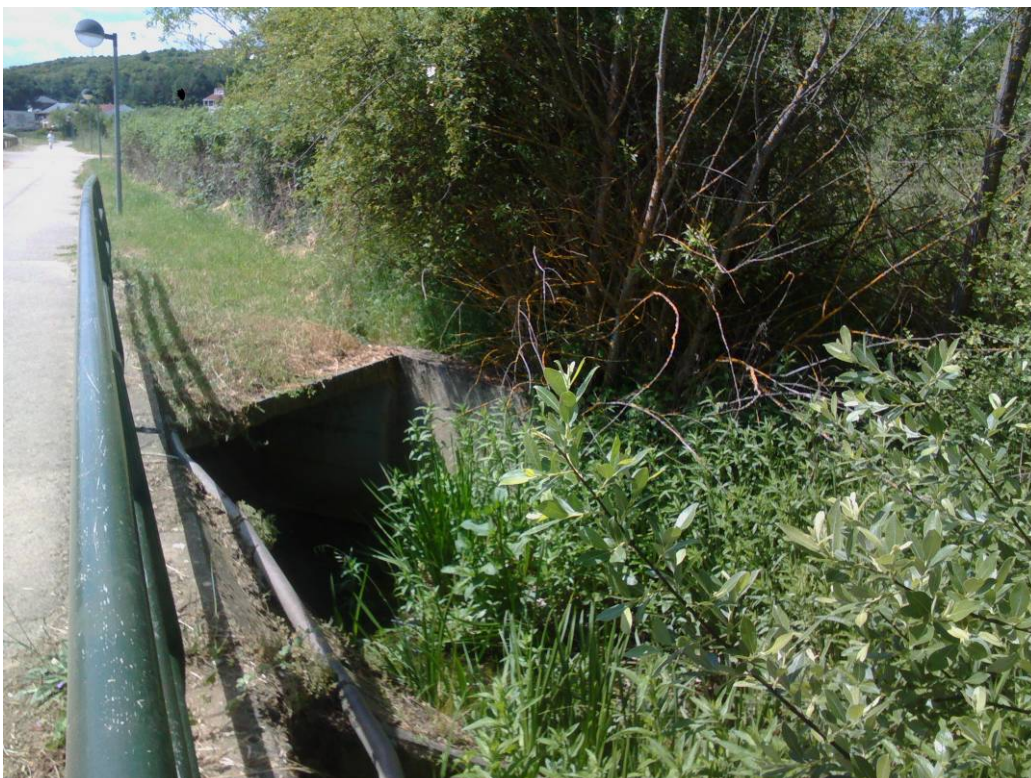
FOTOGRAFÍA 1. Obra de fábrica OD-1 aguas arriba.
