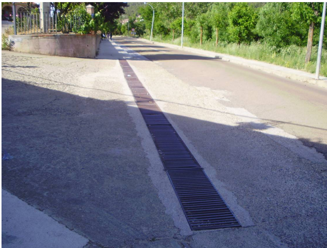
FOTOGRAFÍA 11. Vista del canal abierto próximo a los sectores de Suelo Urbano No Consolidado.
