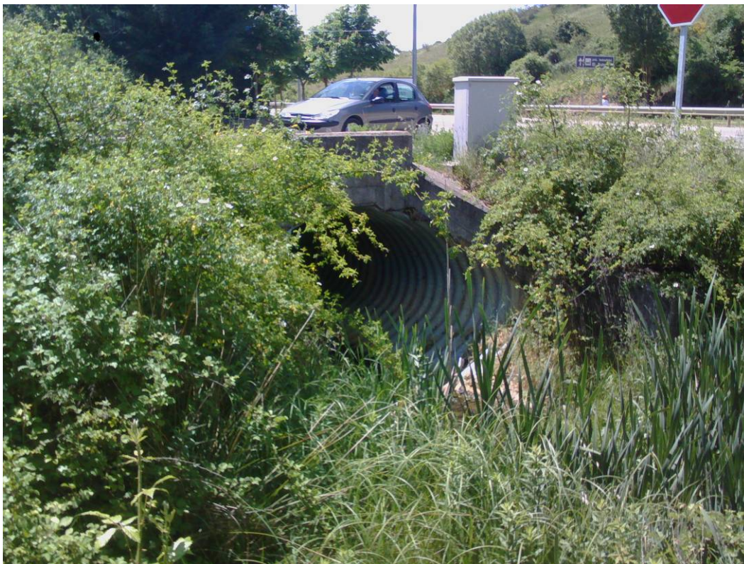
FOTOGRAFÍA 4. Imagen de OD-2 aguas abajo.
